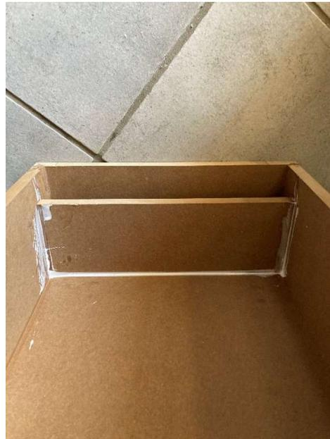
An die Kante klebt man in die Mitte die Stabilisierung die man mit der Lochkreissäge bearbeitet hat und zeichnet an die Seitenwände innen wieder eine Linie mit Abstand 35mm.
